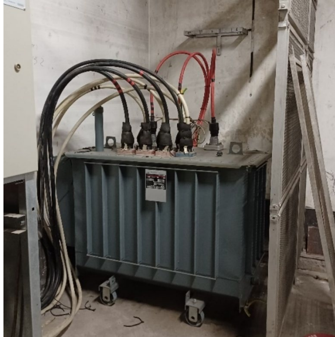
Figura 11 – Vista trasformatore di distribuzione MT/BT esistente
